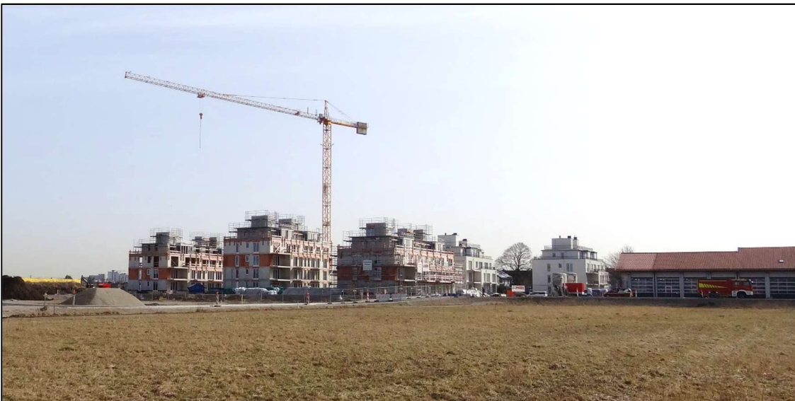
Abbildung 11: In Bau befindliche Wohngebäude „Südlich Hochrainweg“ (Foto DWD, 2021)
