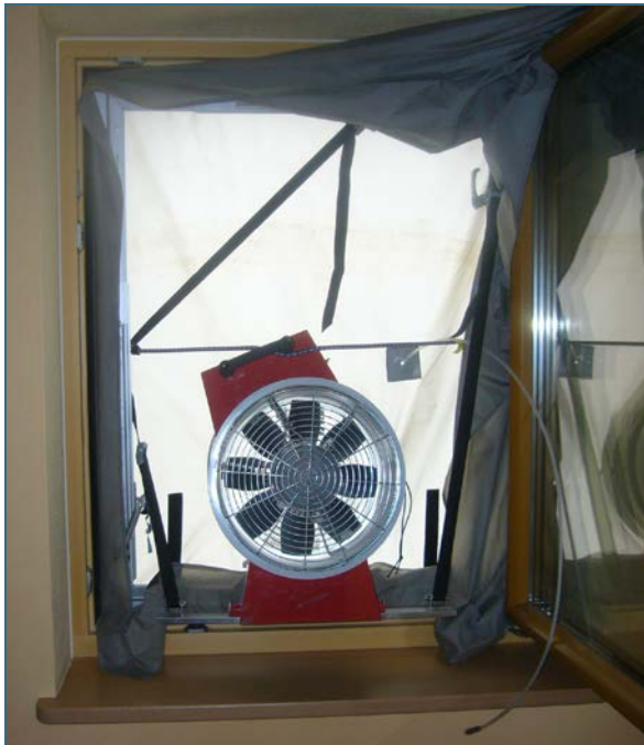
Abb. 16: Luftdichtheitstest zur Qualitätskontrolle in einem Wohnhaus.
