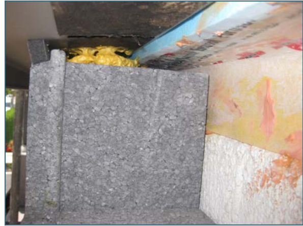
Abb. 21: Besonders wichtig ist gerade im Sanierungsfall das wärmebrückenfreie Ausschäumen der Hohlräume zwischen Fensterblech und Mauerwerk (hier unvollständig ausgeführt).
